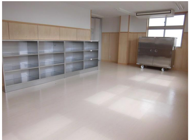
水巻南中学校2階配膳室
