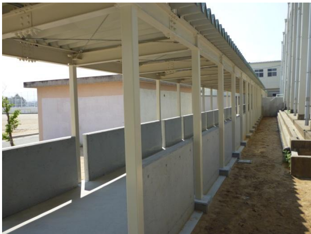
南中配膳室へつながっている渡り廊下
