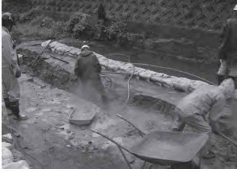
工事で掘削された川床（平成15年）
