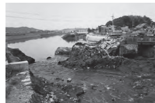
曲川伏越撤去（昭和61年）
