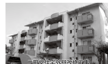
二町営住宅外壁改修工事
