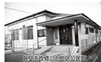
外壁を改修した二区公民館
