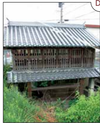
D7 寿命唐戸 (八幡西区楠橋) 1804年完成した水門。構造は中間唐戸と同じです。
