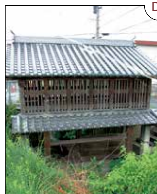
寿命唐戸（八幡西区楠橋） 1804年完成した水門。構造は中 間唐戸と同じです。
