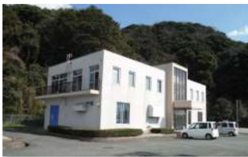
《高松汚水中継ポンプ場（管理棟）》
