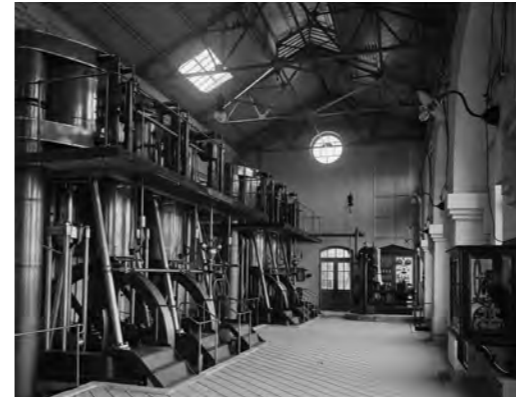
上) 新日鐵住金(株)八幡製鐵所まで、毎日12万トンの水を送っている鉄管道路。 下) ヘイソーン・デビー社製の蒸気エンジンポンプ。ポンプの高さは地上5m、地下2mにもなります。 左) 世界文化遺産に登録された構成資産の一つ、遠賀川水源地ポンプ室。(写真提供：新日鐵住金(株)八幡製鐵所)
