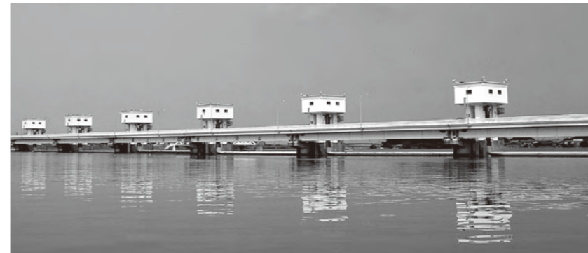
遠賀川河口堰
