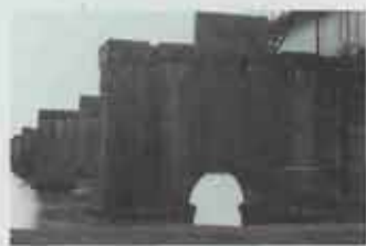
◀今も残るレンガ造りの橋脚 (中間市)
