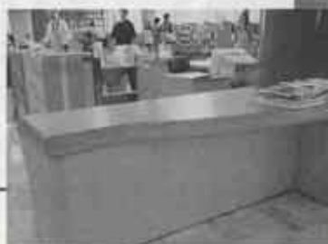
▲車イス用に出っ張りを大きくとり、手渡ししやすいように曲線をつけたカウンター。（刈田町）
