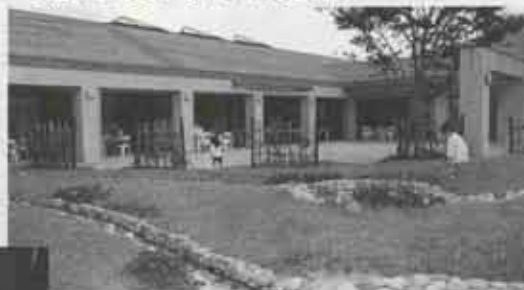
▼全館を回廊の様に取り巻く軒付の通路。中庭は親水公園になっています。（伊万里市）
