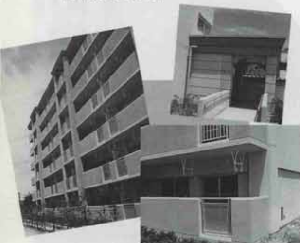
●写真は頃末の県営住宅です。
