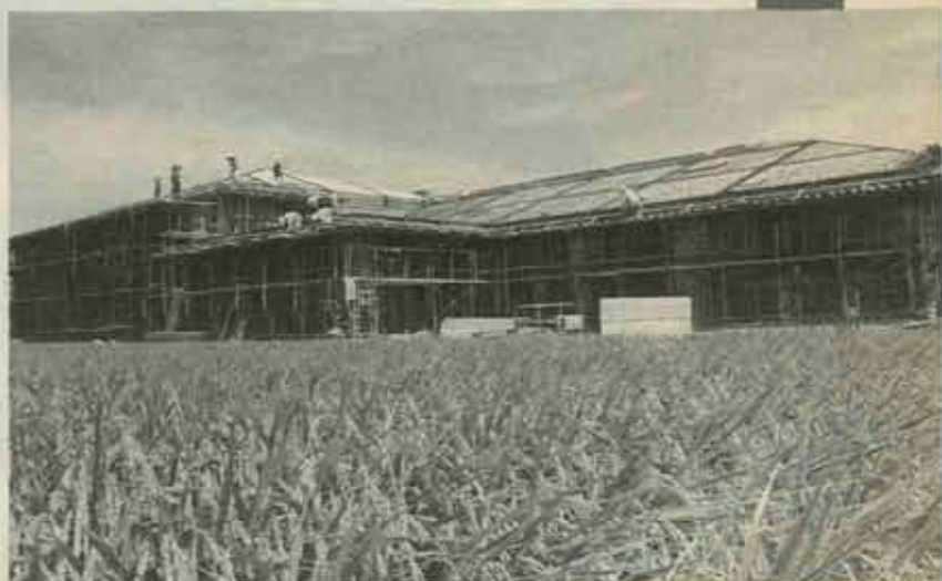
黄金色の稲穂に囲まれて建設中の南部公民館
