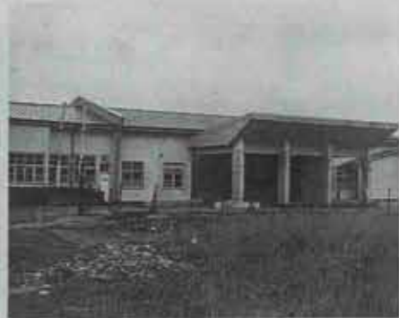
●町民会館完成（昭和30年）
