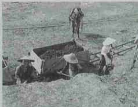
●頃末地区の鉱害復旧作業（昭和32年）
