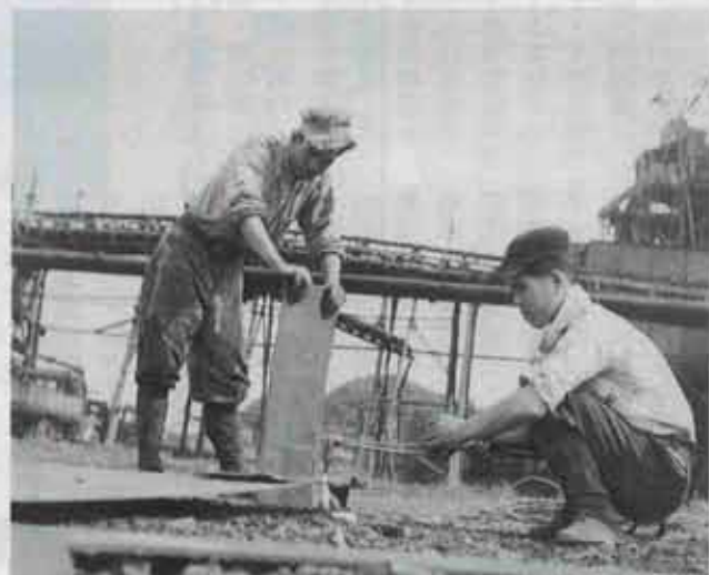
昭和32年 ガス機で鉄板を切断する作業員 (二砥選炭機付近・現吉田団地)
