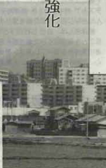
林立する公営住宅群
