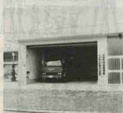
完成した第3分団の格納庫。 消防団本部と団員の詰所も完備
