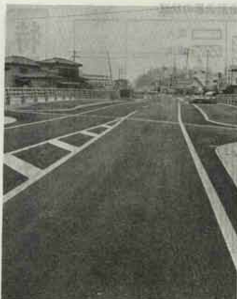
山陽大橋の工事も完了し、開通した砂山・丸ノ内線
