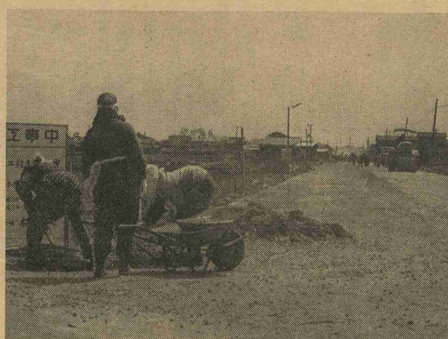
生活基盤整備の基本となる道路整備事業 頃末一線
