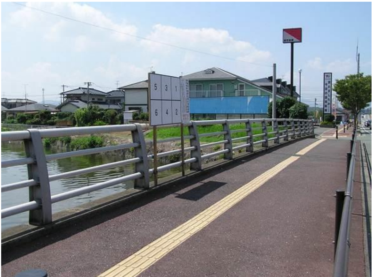
7-2 樋口 1 番 曲川大橋（酒のこがね屋西側）
